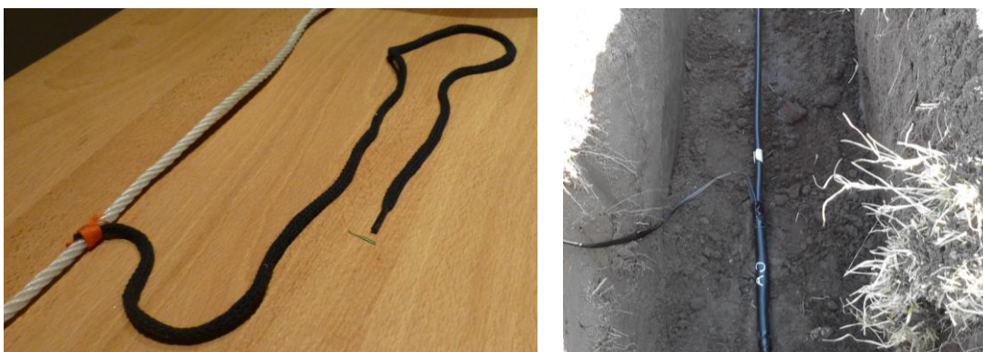
Figuur 4 links: Schematisch beeld van een goede aanleg, waarbij signaalkabel (wit) en koofstofilint (zwart) in een vlak worden aangelegd, maar wel op een of meer decimeters boven het folie. Figuur 4 rechts: feitelijk beeld van heraanleg, met daarin het carbonlint dat zonder lus naar boven wordt gevoerd (bron: Provincie Zuid-Holland)
